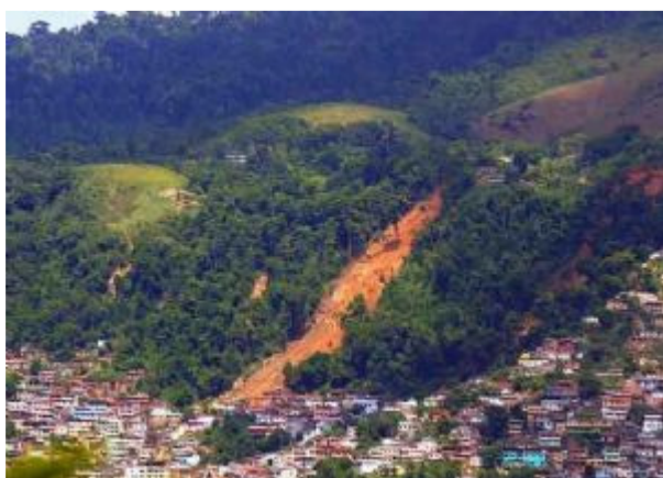
Deslizamento no Morro da Carioca, em Angra dos Reis (RJ) provocou dezenas de mortes
